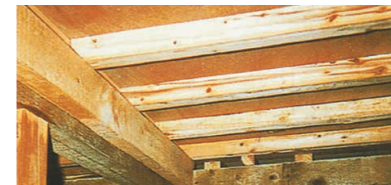
B 床下換気扇を設置している床下
